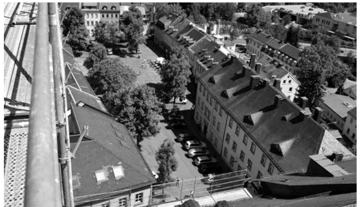
Blick vom Baugerüst auf den Maxplatz in Hof mit dem Dekanat (etwa in der Mitte rechts).
